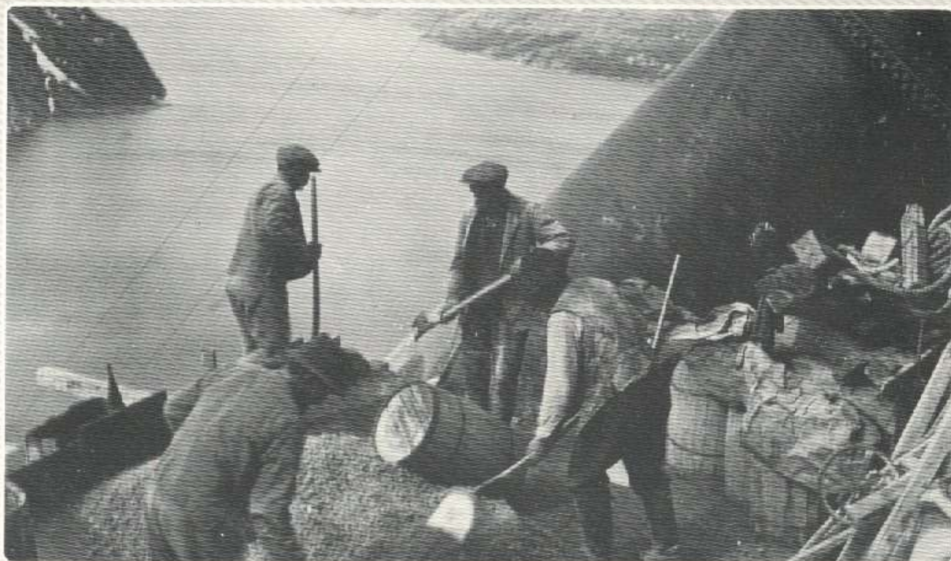
Utlånt Glomfjord Kraftverk
